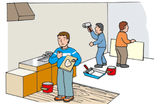
在对公寓进行室内改装施工的过程中，粘合剂中所含有机溶剂蒸汽被引燃后发生爆炸，致使3名施工人员受伤停工。
