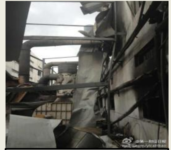
厂房车间外除尘管道
