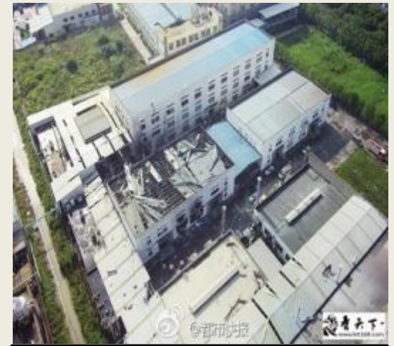
空中航拍的爆炸车间
