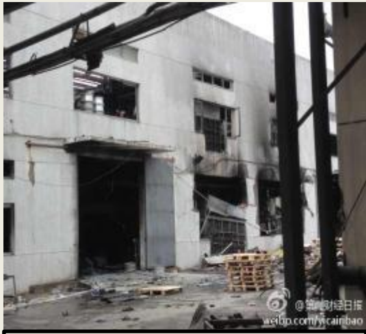
厂房车间外部
