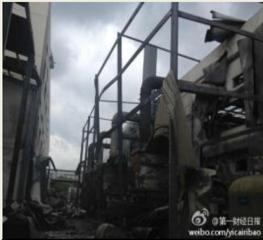
厂房外排风管道
