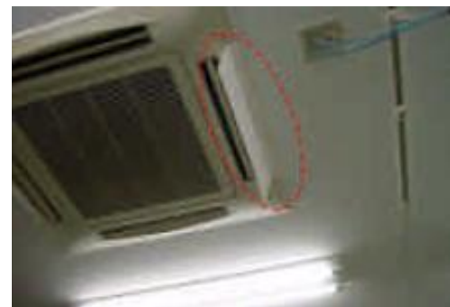
改善通风换气条件
