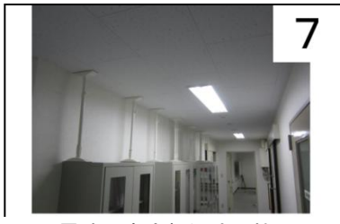
7 地震時の書庫転倒防止棒の設置
