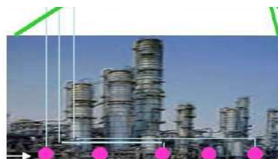
ガス漏洩検知器（20箇所）
