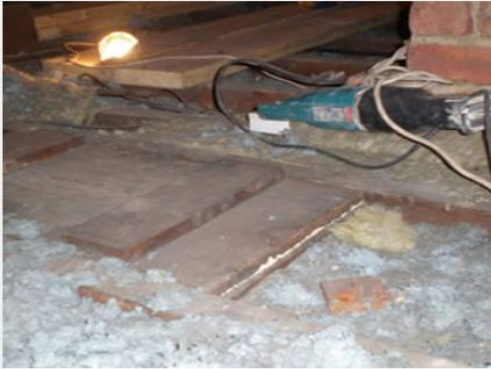
Loose-fill asbestos
