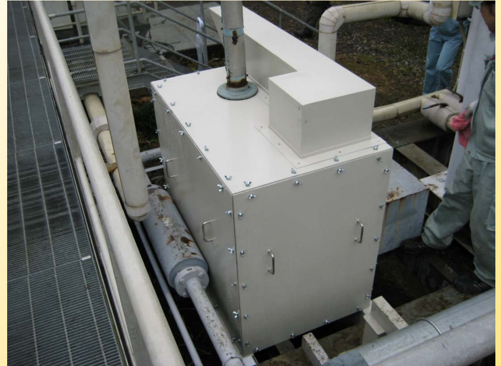
＜防音ボックス設置後＞
