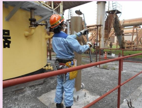
シールポット点検訓練 ミラー使用による水位等確認
