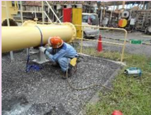
ガス漏れ補修訓練 シール剤による閉止処置
