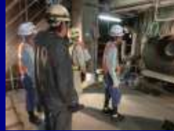
タンク内酸欠作業の確認
