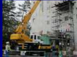
移動式クレーン作業の確認
