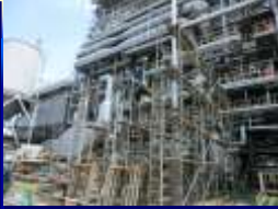
足場の組み立て作業の確認
