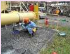
ガス漏れ補修訓練 シーラ剤による閉止処置
