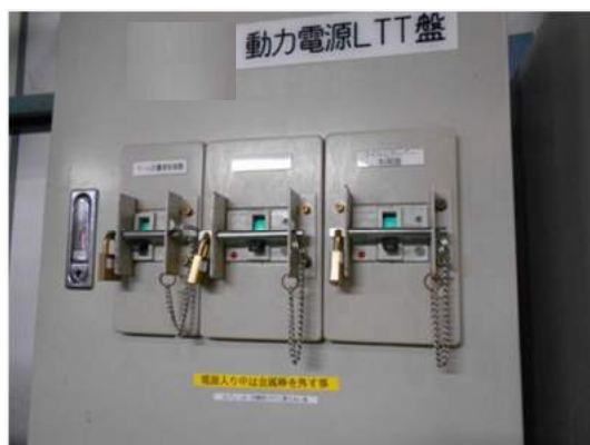
図 206 元電源の不意起動防止の事例
