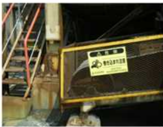
①ベルトコンベアのテール部に安全カバー設置 (注意喚起標示)
