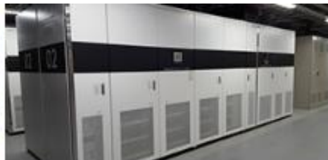
受変電システム (UPS)
