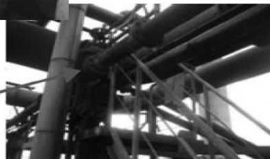
仕切板取付 場所
