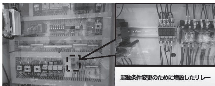
写真2 増設したリレー
