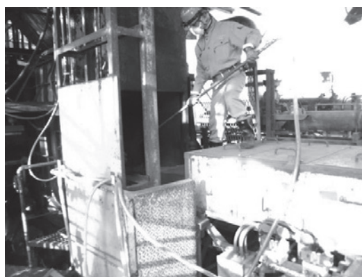
写真 1 堆積廃棄物除去作業
