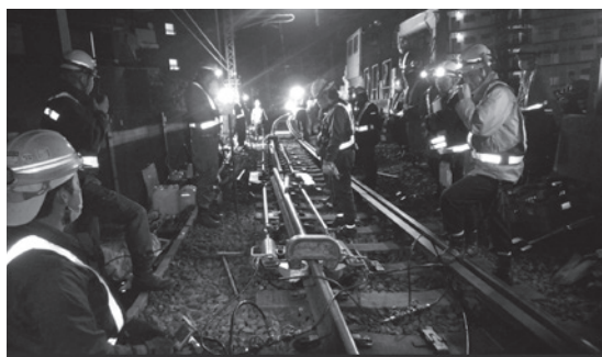
写真1 レール緊張状況（設定替え）
