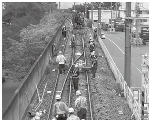
写真 1 代表的な作業（レール交換）
